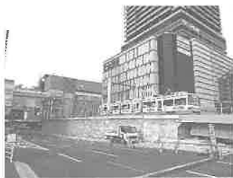
【広島駅への乗り入れ工事】
