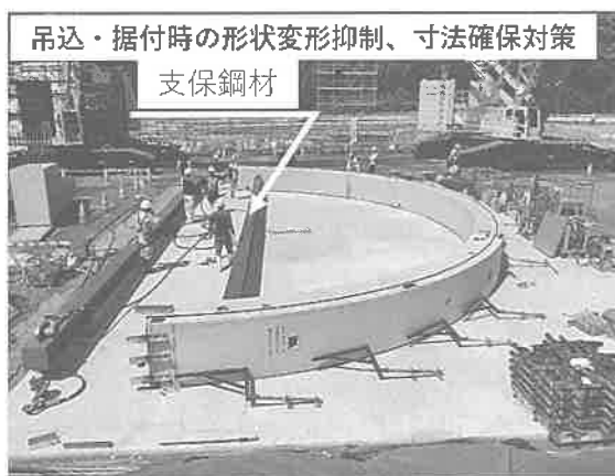
図-3 支保鋼材設置状況
