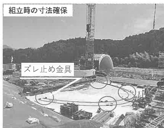
図-1 ズレ止め金具4箇所設置状況
