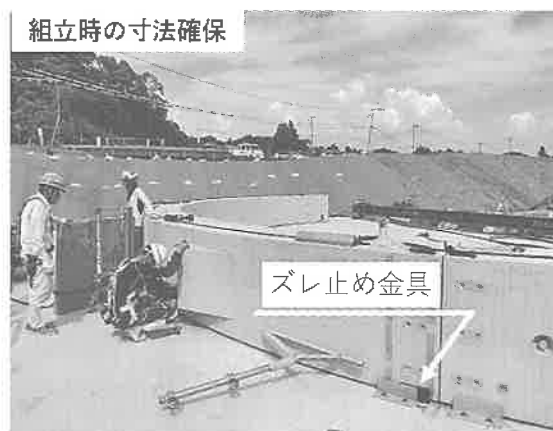
図-2 接合部ズレ止め金具
