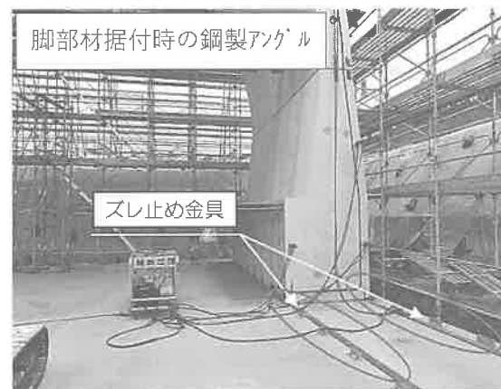
図-5 ズレ止め金具設置状況
