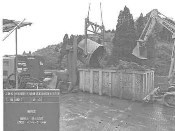
写真-10 大型排土バケットの開閉治具
