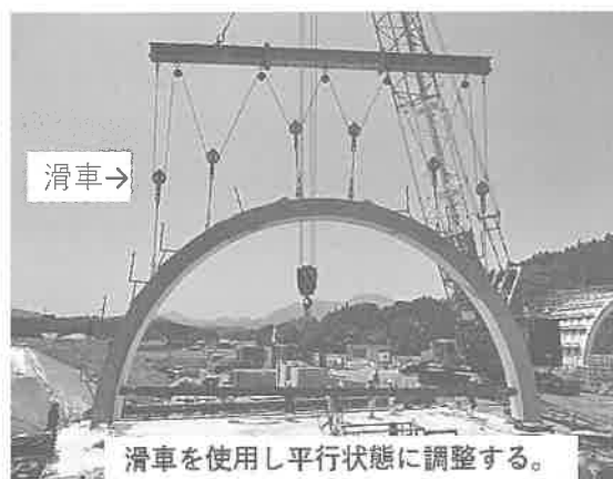
図-4 アーチ部吊上げ状況
