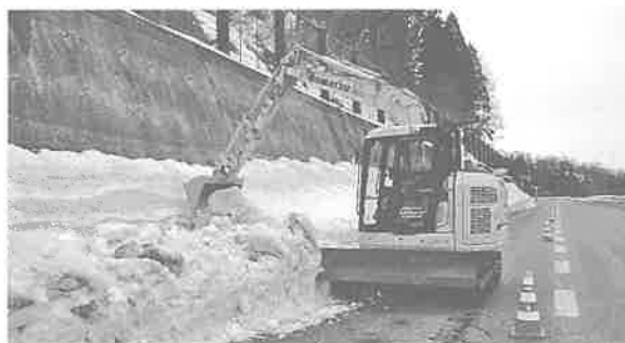
図-5 ICTバックホウ作業状況
