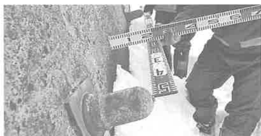
図-4 擁壁のアンカーキャップ
