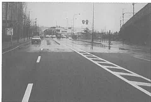
写真2 都道環状7号線に適用された排水性舗装 (手前側：排水性舗装)
