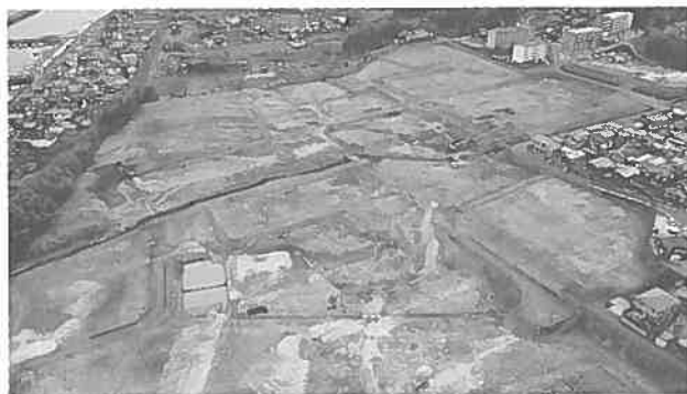
ドローンによる現場空撮
