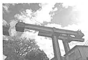
工事現場見学会
