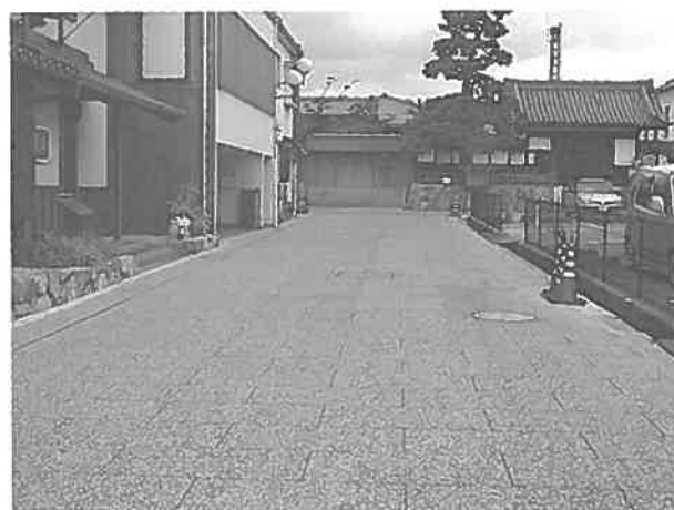
写真1 石畳風の半たわみ性舗装
