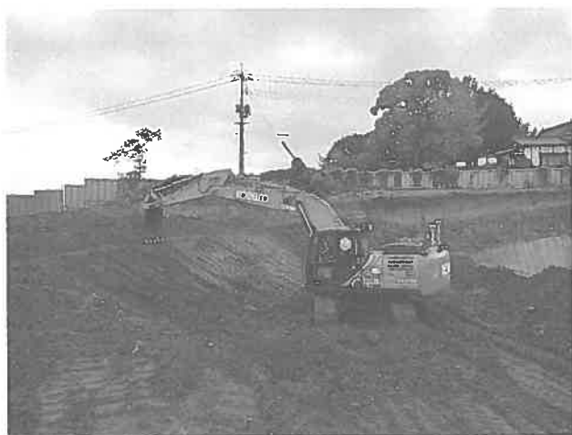
ICT重機による土工
