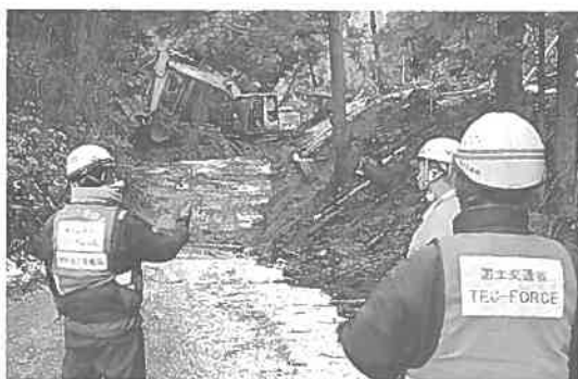
写真5－建設業団体等と連携した道路の緊急復旧 (石川県輪島市)
