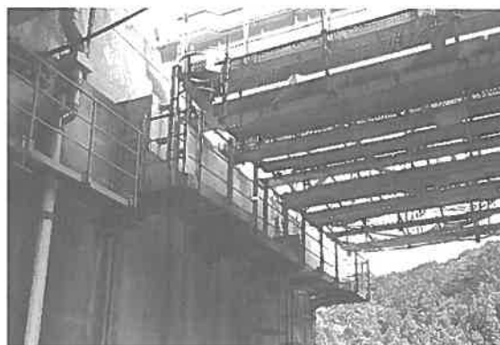
図-13 現地の設置状況
