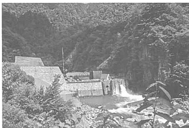
黒部奥山で建設中の砂防堰堤（写真①）
