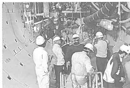
放水路工 シールド工切り刃部
