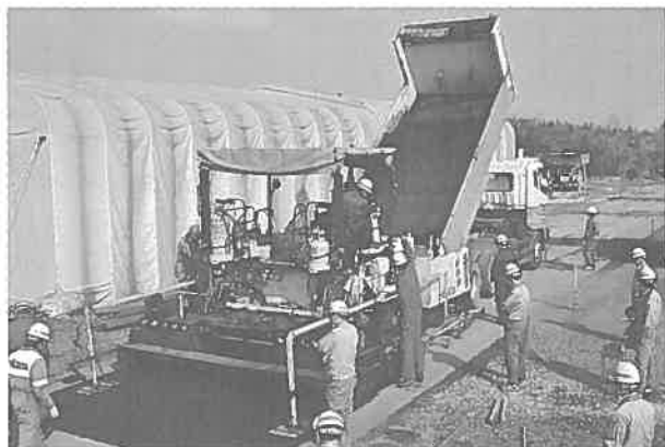
写真2 アスファルトフィニッシャー
