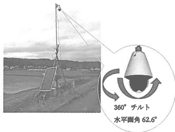
IOTカメラ・ソーラー発電設置状況
