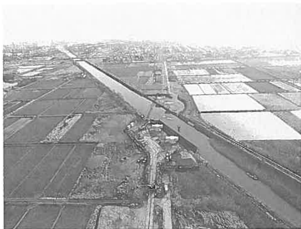
工事現場全体 (写真①)
