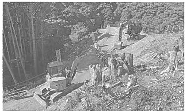
大小のICT建機による小規模工事
