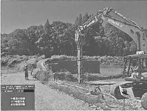
(写真-3) 飛散防止対策の様子
