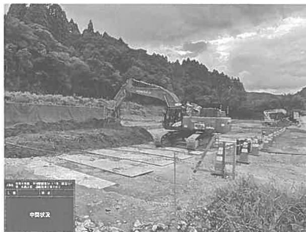
(写真-2) 地盤改良施工の様子
