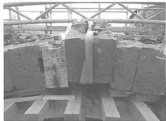
図-4 輪石組み2回目（下流側）
