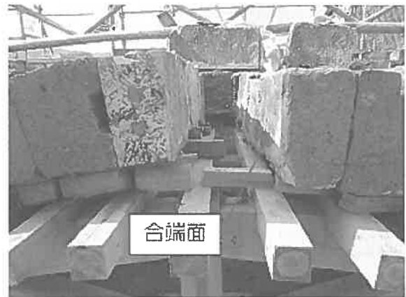
図-3 輪石組み1回目（下流側）
