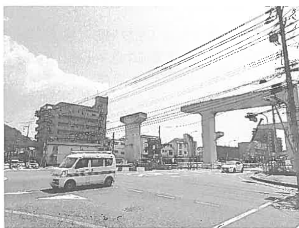
図-2 架空線状況
