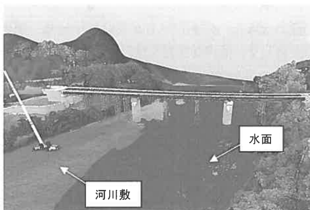
図-3 平常時から2.5m水位上昇したヤード
