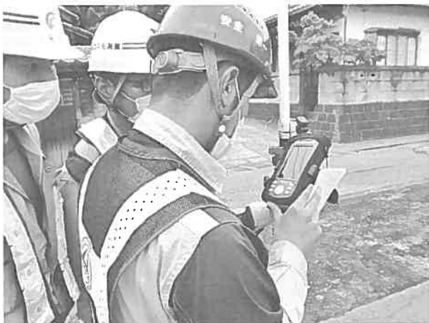
写真-8 切削後の出来形測定
