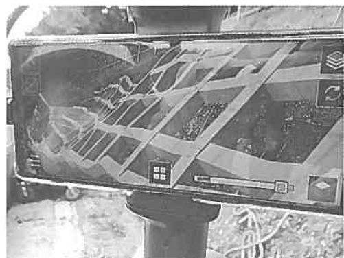
図-8 MR技術活用による芯出し作業
