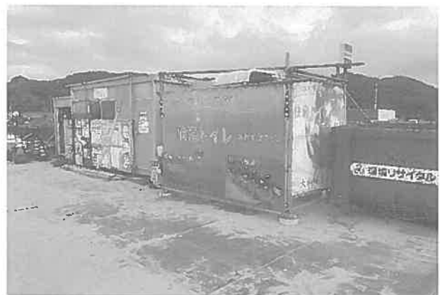
目隠しスクリーン設置
