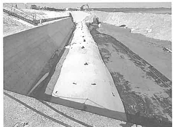
サンドバック施工状況
