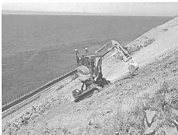
ICT施工状況
