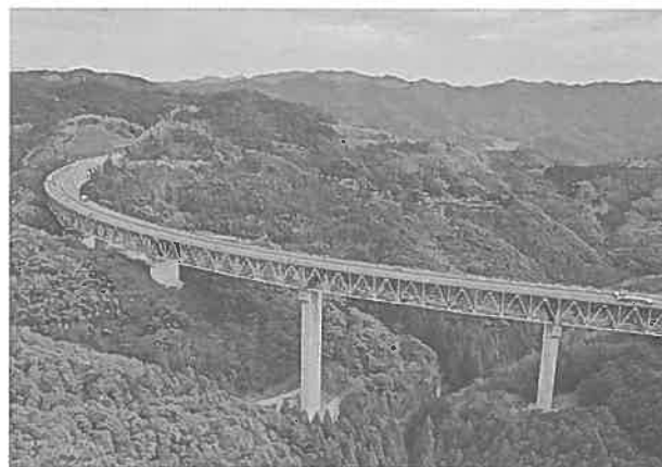
図－1 曾我部川橋 全景
