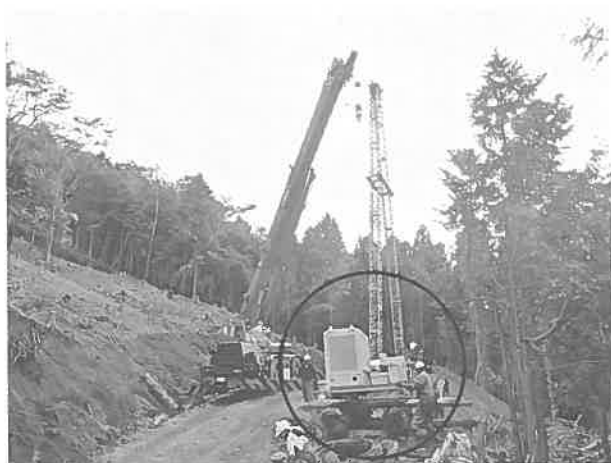
（写真－7）集材機（ウインチ）据え付け
