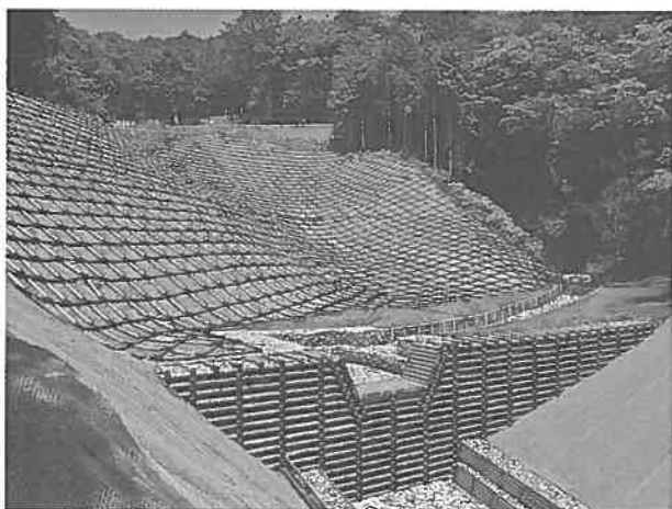
(写真-10) 校倉式土留工と丸太法枠工
