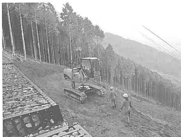
（写真－9）重機組立状況 （ケーブルクレーンを使用し施工箇所まで組立）
