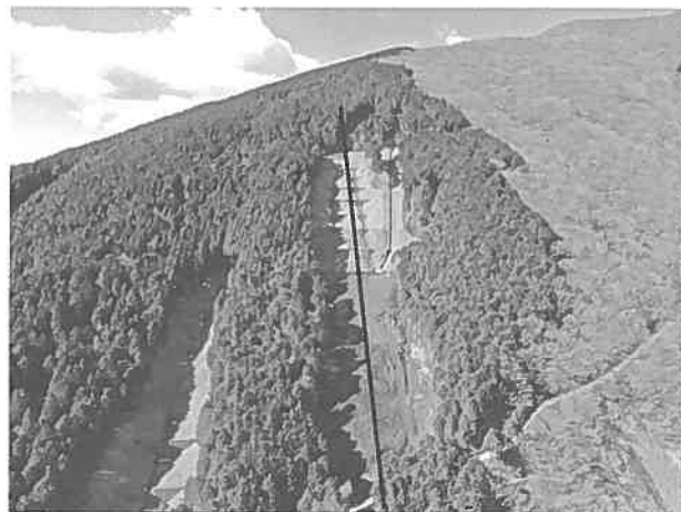
（写真－４）崩壊地② 継続工事で上部より施工中 黒線はケーブルクレーン法線
