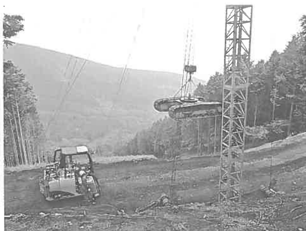
（写真－8）重機分解、運搬状況 （重機を分解し、組立順に施工箇所まで運搬）
