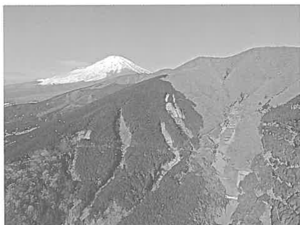
（写真－1）事業体の一部、角取山地区を施工中
