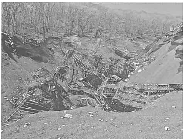
（写真－３）崩壊地① 土石流の発生が多い （下写真は土石流により崩壊した既設構造物）
