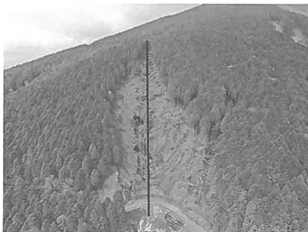
（写真－５）崩壊地③ 被害木処理から施工 黒線はケーブルクレーン法線
