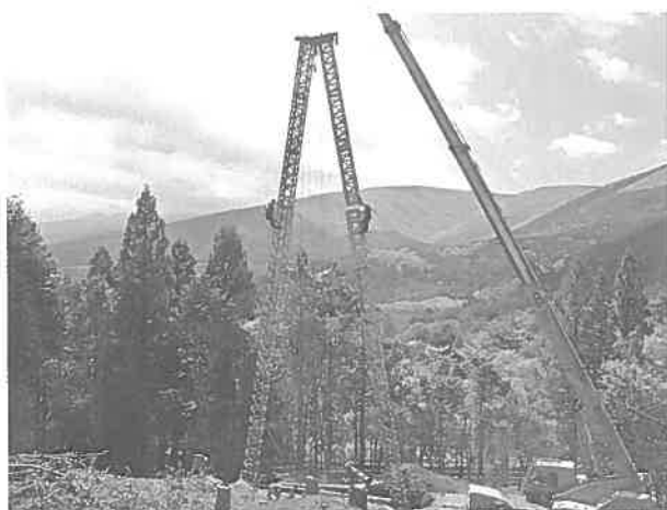
（写真－6）上部下部支柱建て込み H=24.0m （崩壊地縦断勾配により支柱高は変化）
