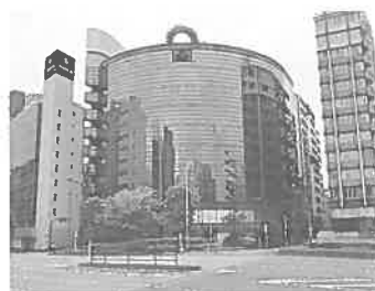
技士会事務局のテナントビル
