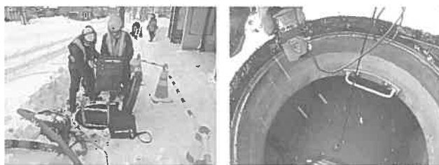
写真－７ 有毒ガス濃度等の測定
