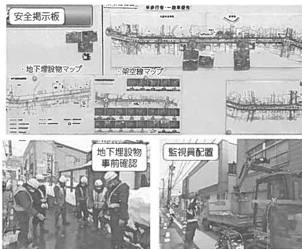
写真-4 公衆災害防止対策
