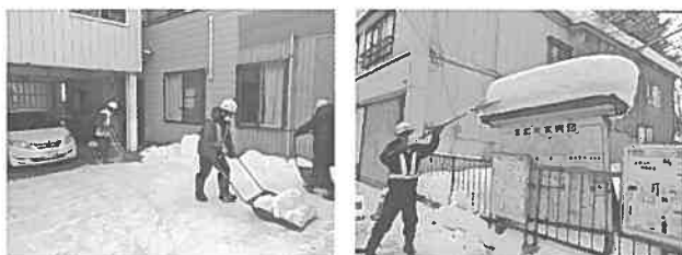
写真-3 工事箇所沿線の除雪
