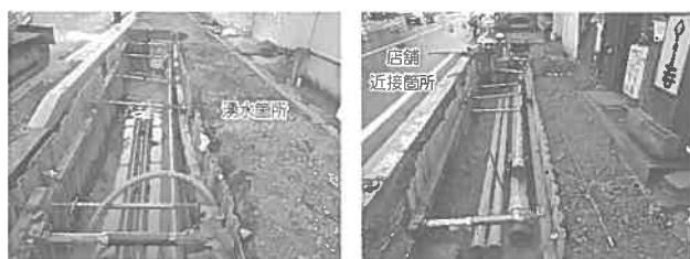
写真－６ 仮設土留めによる土砂崩壊防止
