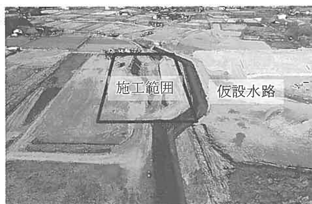
写真－2 施工範囲（工事中）（著者撮影）
