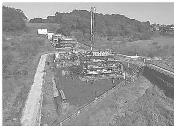
写真－1 橋梁下部工を施工
