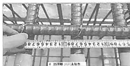
写真－3 配筋検査の数値確認
