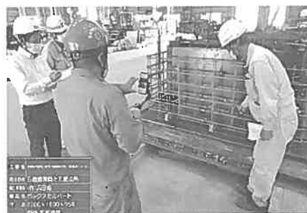
写真－5 立会状況（現場側）
