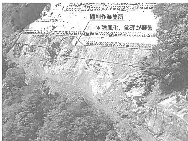
図-3 掘削作業箇所
