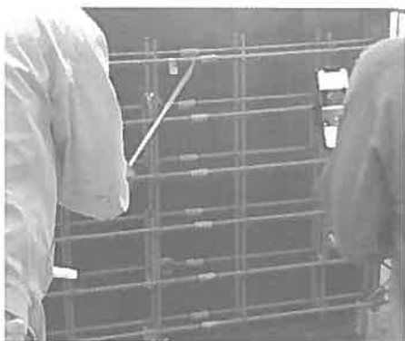
写真-7 鉄筋種類ごとにマーカーを設置
