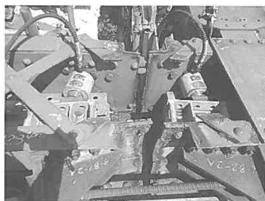
(b) 切断後（ジャッキ解放前）
