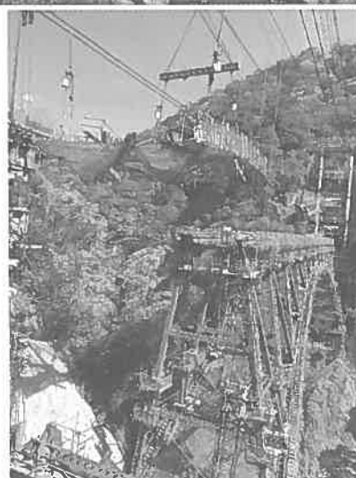
図-8 旧橋撤去状況
