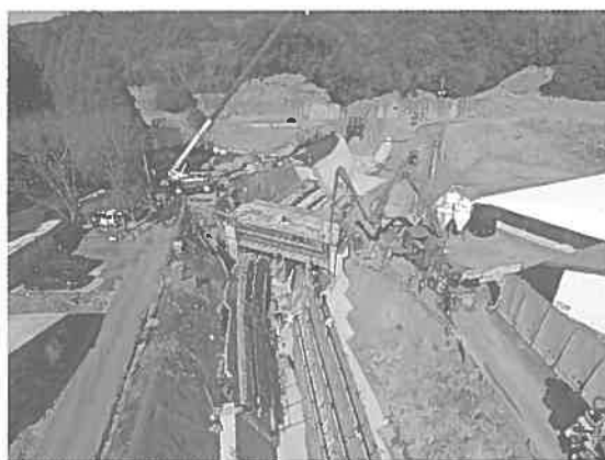
写真－1 下流より擁壁工・上部工・擁壁工を施工中
