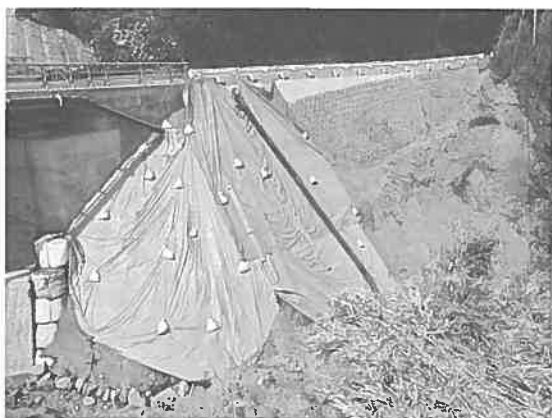
写真-3 擁壁工着手前（ブルーシート部分が押え盛土）
