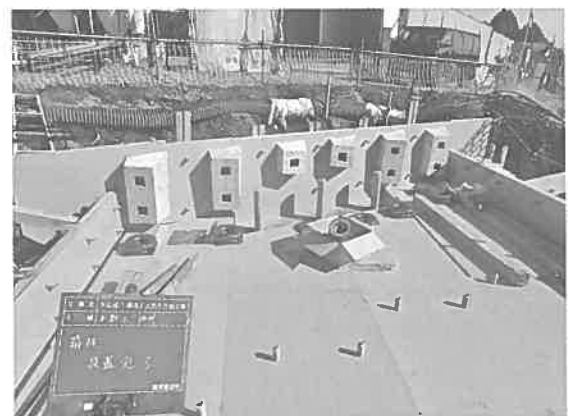
写真-2 箱抜き設置完了
