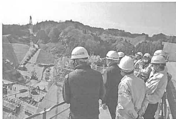
玉来ダム建設現場見学会
