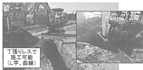
写真2 小規模土工（掘削）検証状況（L字掘削）
