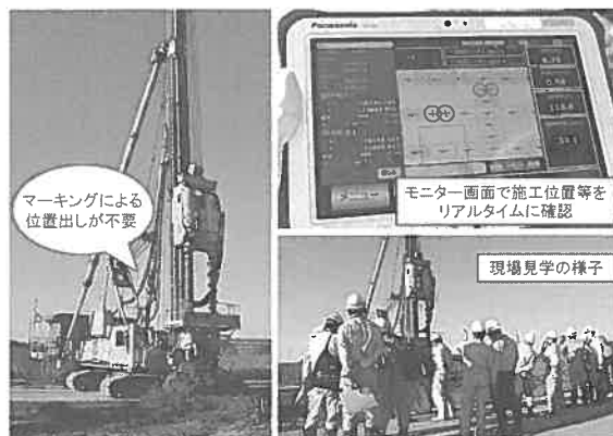
写真5 ICT地盤改良工の講習会実施状況
