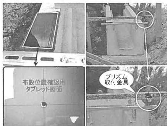
写真6 丁張り機器の活用によるU型側溝据付事例
