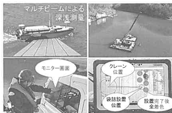
写真7 施工状況とガイダンス画面確認状況
