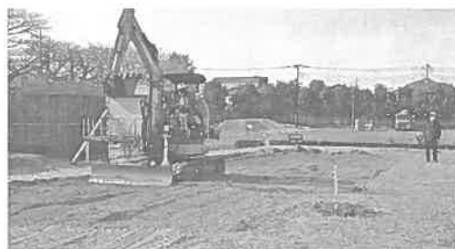
写真1 小規模土工（敷均・整正）検証状況
