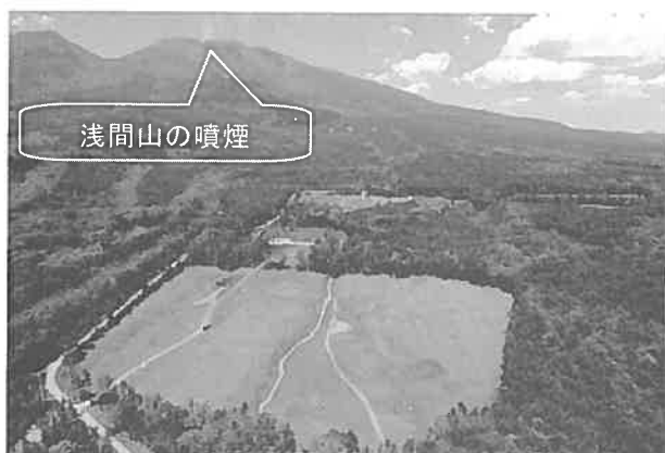
図-1 着工前状況
