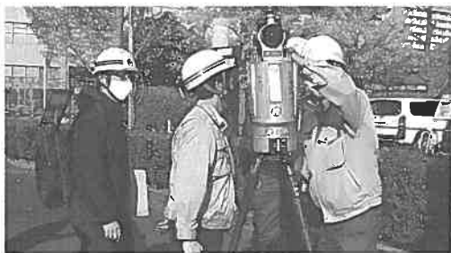
写真4 舗装修繕工におけるICT測量の検証状況
