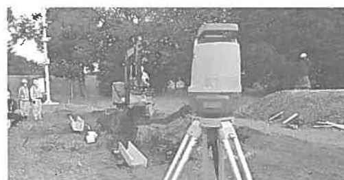
写真3 小構造物設置工の検証状況
