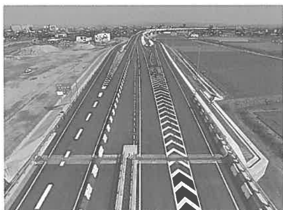
写真-2 供用区間（大川中央IC）
