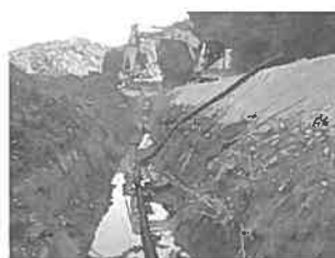
湧水处理施設設置
