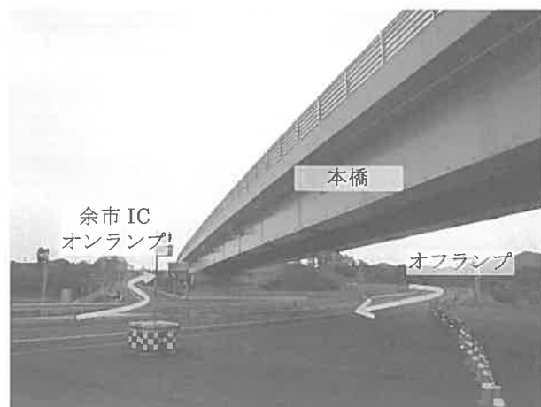
図-2 架設地点の状況
