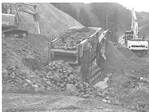
写真-7 ふるい分け作業状況
