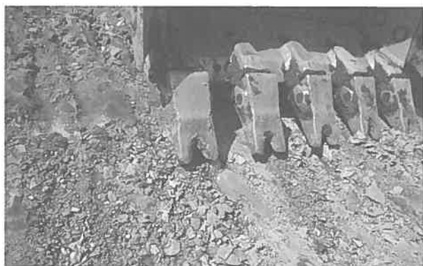
写真-8 法面整形時機械精度確認
