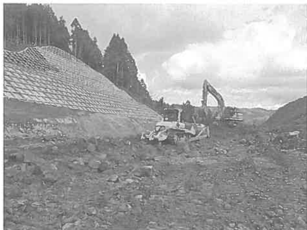
写真－４ リップドーザ掘削状況
