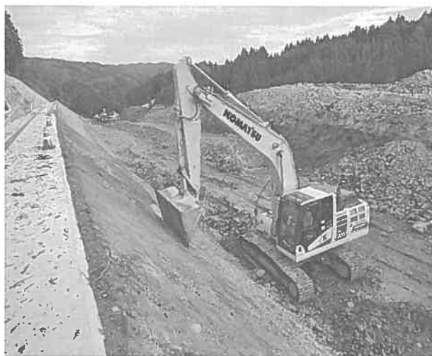
写真－５ 切土法面整形状況
