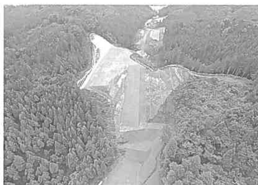
写真－2 2019年8月頃 本工事着工前
