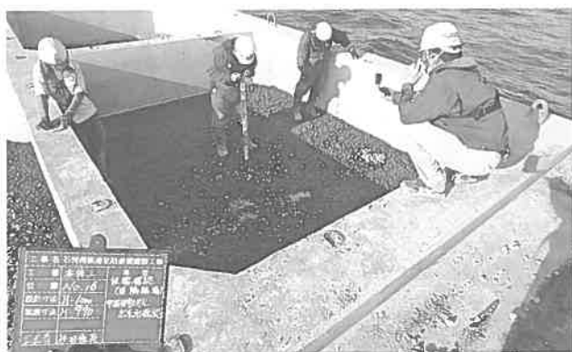
写真－5 中詰材均し出来形確認（海上）
