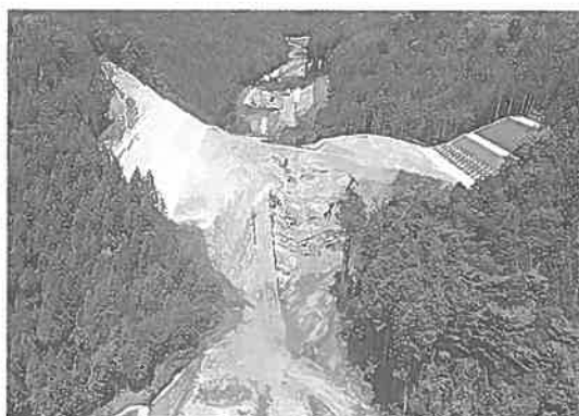
写真－3 2020年8月頃 本工事完成時
