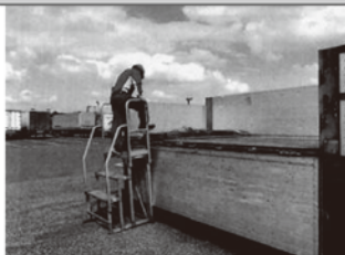
墜落・転落防止：昇降台の導入
