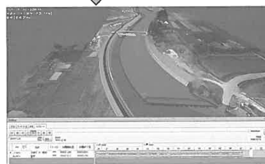
中央部河道掘削
