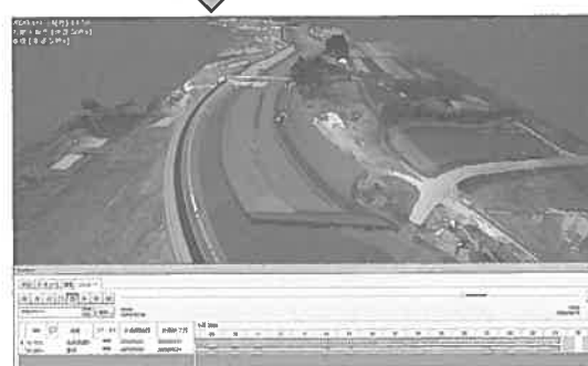
瀬替え後、右岸側施工
