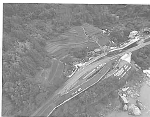
2018：迂回路設置状況
