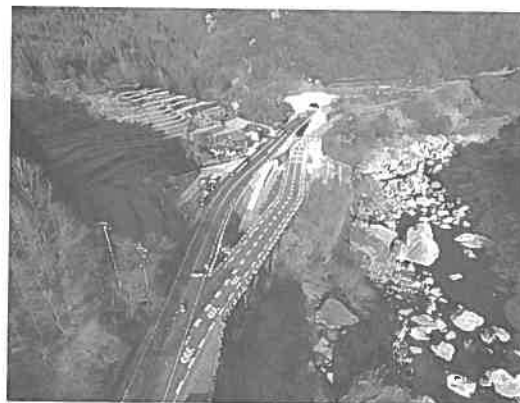
2020年 橋中津トンネル供用開始前
