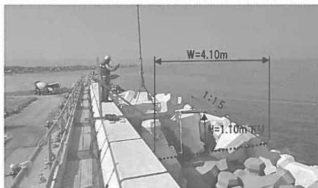
図-9 ブロック据付状況
