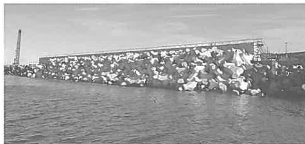
図-10 ブロック据付完了全景
