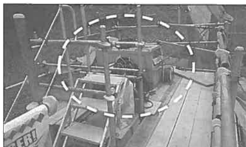
図-6 資機材等配置状況
