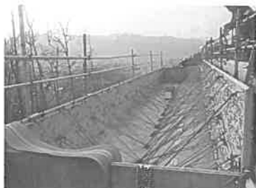
図-2 型枠内部
