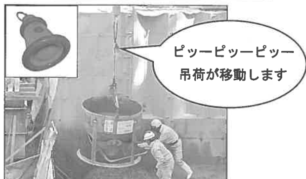
図-12 吊荷警報器取付作業状況
