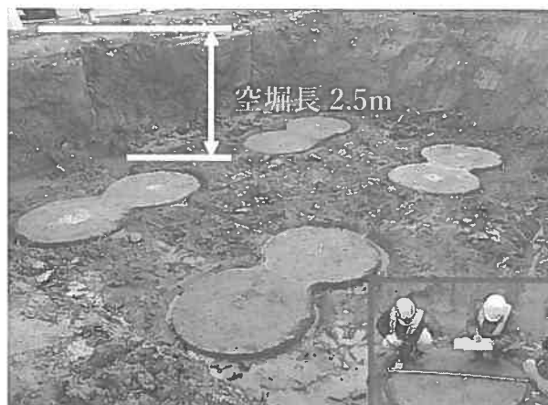
図-2 RMP-MST工法 杭頭出来形確認状況
