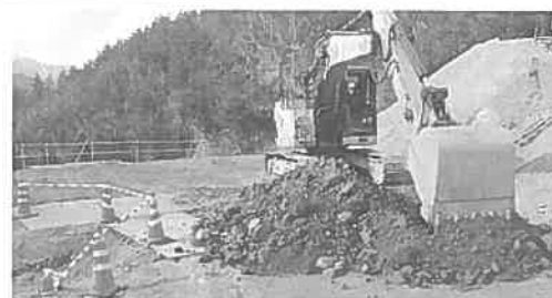
図-14 ロードマット・山砂利敷設
