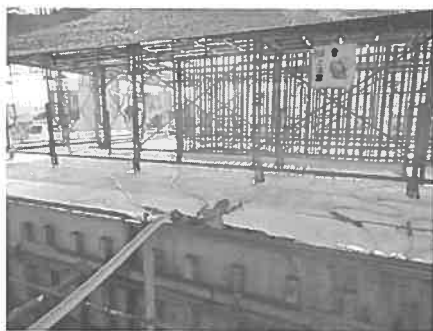
図-10 湛水養生状況
