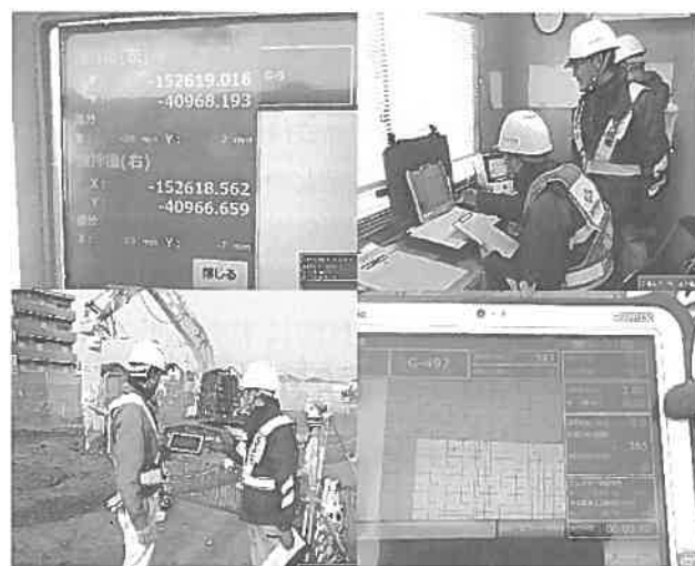
図-3 GNSSステアリングシステム (上：RMP-MST工法、下：SCM工法)
