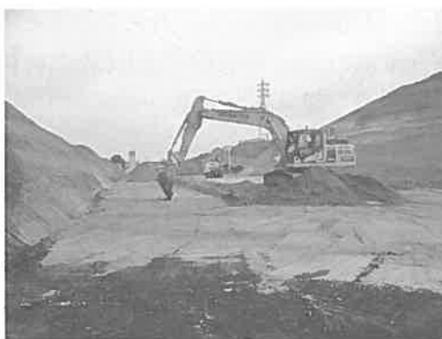
図-6 ICT建機による床付作業
