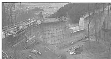
図-5 堤体背面作業通路兼作業足場
