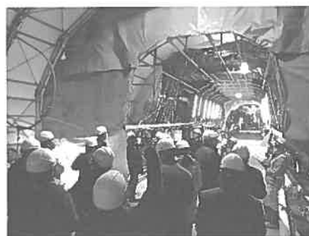
（仮称）北沢トンネル本体工事の現場視察会
