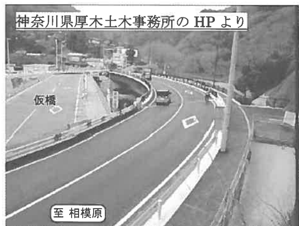
図-3 新橋供用状況
