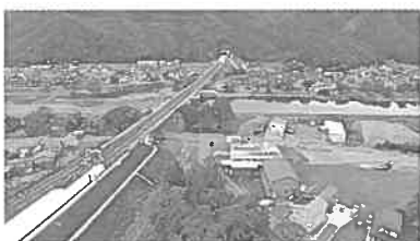
三陸沿岸道路（大槌IC付近）
