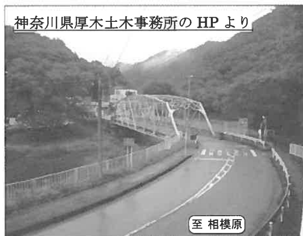
図－1 旧橋供用時
