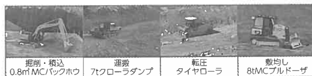
図-2 ICT建機による施工状況
