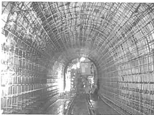
図-10 覆工の複鉄筋組立
