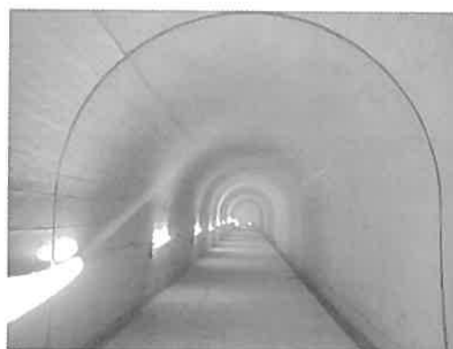
図－１ リムトンネル完成写真
