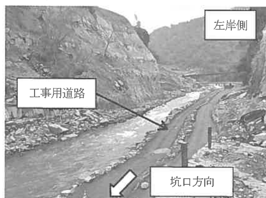
図-5 工事用道路
