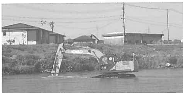
図-6 ICT建機による水中掘削
