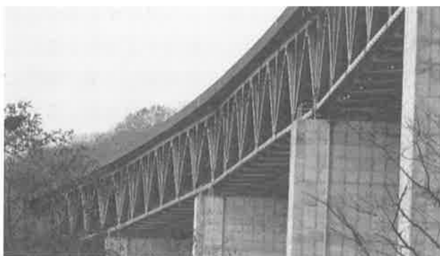
図-1 道央自動車道メップ川橋
