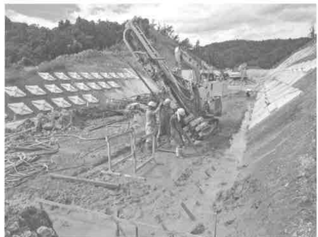
図-8 掘削用仮設対策工 (スリット鋼管)
