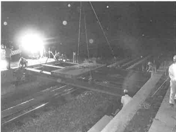
図-2 仮橋架設状況
