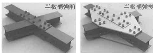
図-2 下横構部材交差部当板材の施工例
