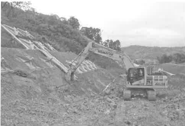
図-3 法面整形 (ICT建機)
