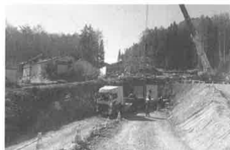
図-5 製品搬入状況
