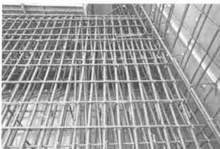
図-4(2) 端部配筋状況 (図-3 A部)
