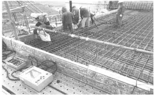
図-9 コンクリート打設状況
