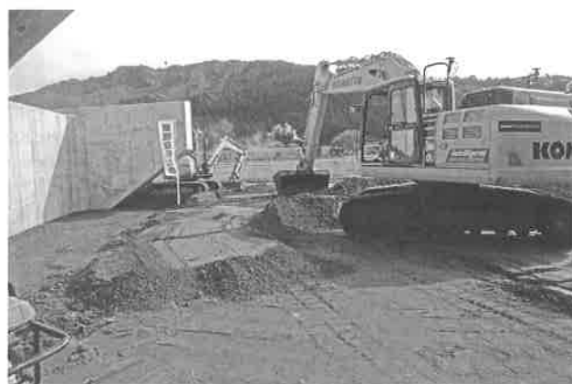
図-3 MCバックホウ敷均し
