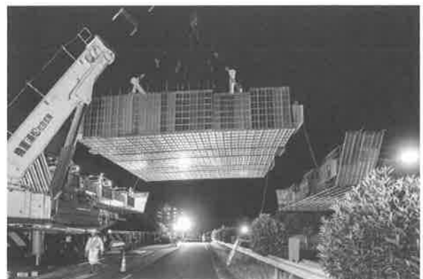
図-5 夜間一括架設状況
