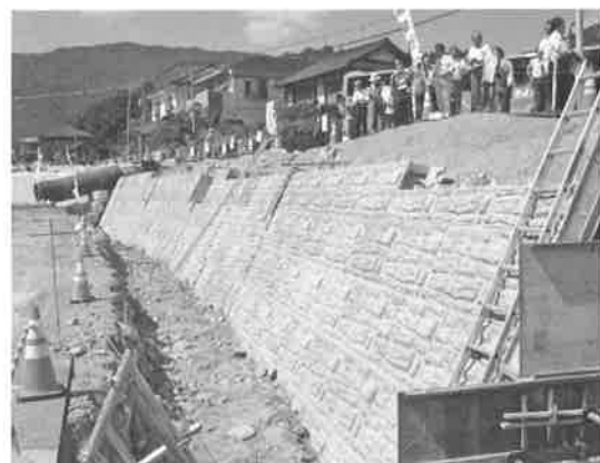
<野呂川護岸復旧工事状況>
