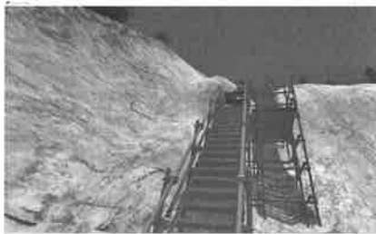
図-4 安全点検箇所の確認
