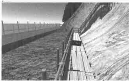
図-3 安全点検箇所の確認
