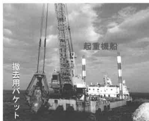
図-2 ブロック撤去状況
