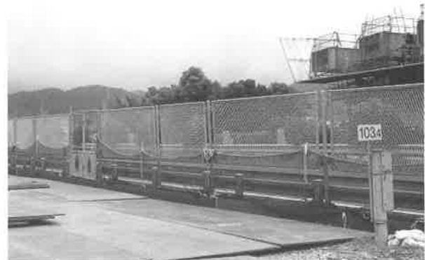
図-7 H鋼ガードレール+防護フェンス
