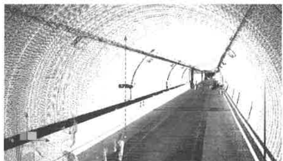
図-6 トンネル内部の高さ計測の一例
