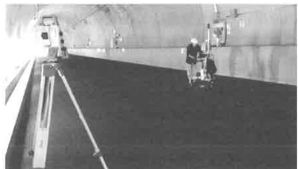
図-4 地上移動体搭載型LSによる計測状況
