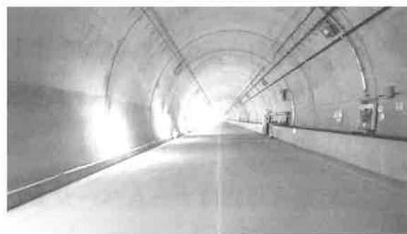
図-1 トンネル内部
