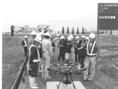
図-6 3次元起工測量現場見学会開催状況
