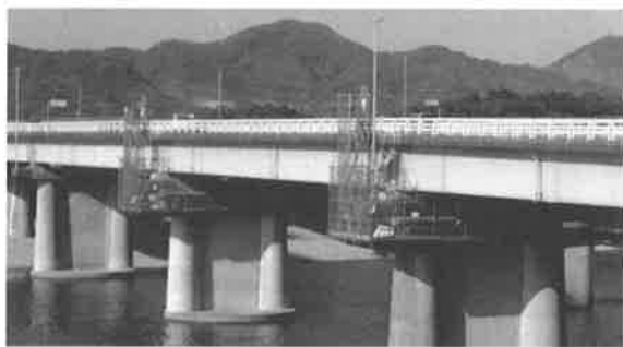
図-9 足場支保工の組換え後
