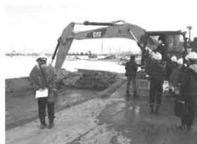
図-8 ICT施工 現場見学会開催状況
