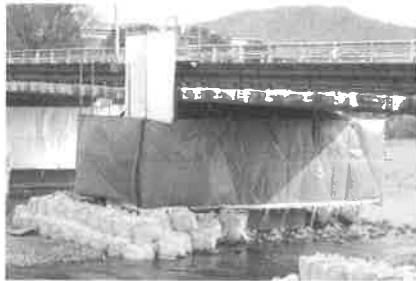
図-3 足場外部養生
