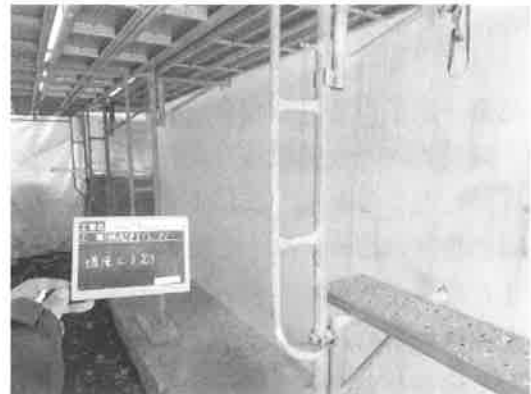
図-8 養生撤去完了時
