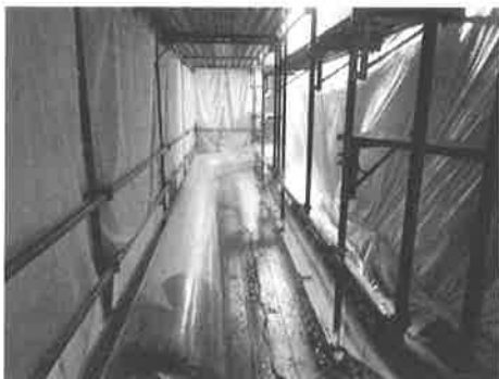
図-7 夜間の養生
