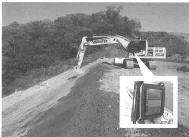
図-3 ICT建機による法面整形
