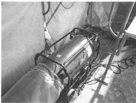
図-6 ジェットヒーター設置
