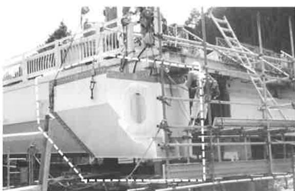
図-7 ⑤部分取替えによる主桁補修
