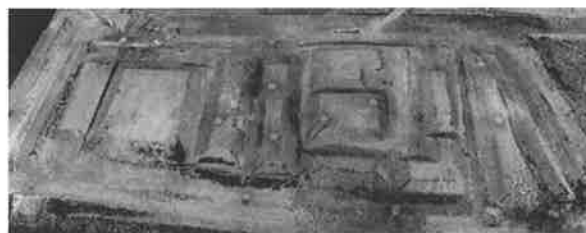
図-2 施工前の状況（3次元起工測量）
