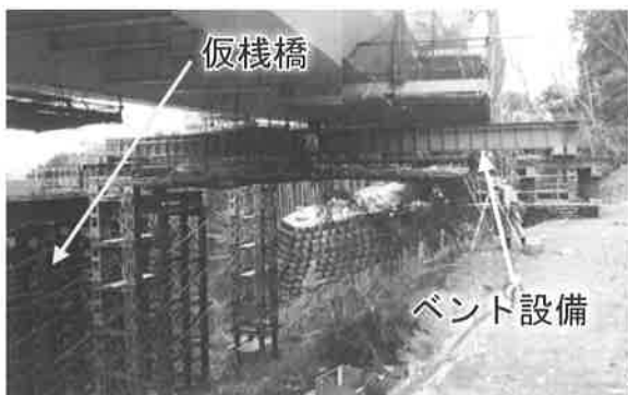
図-6 ①仮栈橋と②ペント設備
