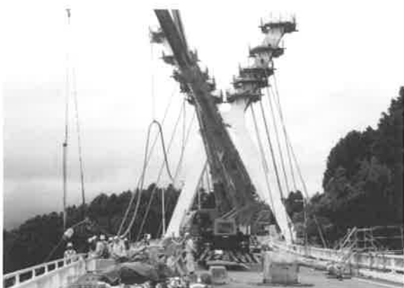
図-8 ⑦斜ケーブル撤去状況
