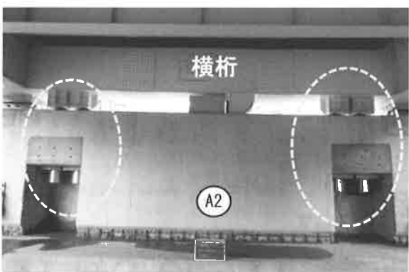
図-9 ⑨負反力対策工 PCケーブル設置
