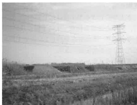
図-1 施工前の状況
