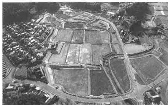
図-12 本工事現場の空中写真（施工後）
