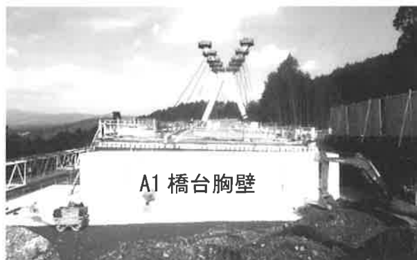
図-11 ⑩胸壁再構築
