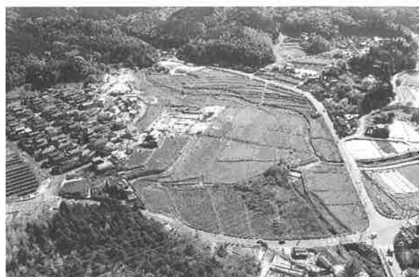
図-1 本工事現場の空中写真（着工前）
