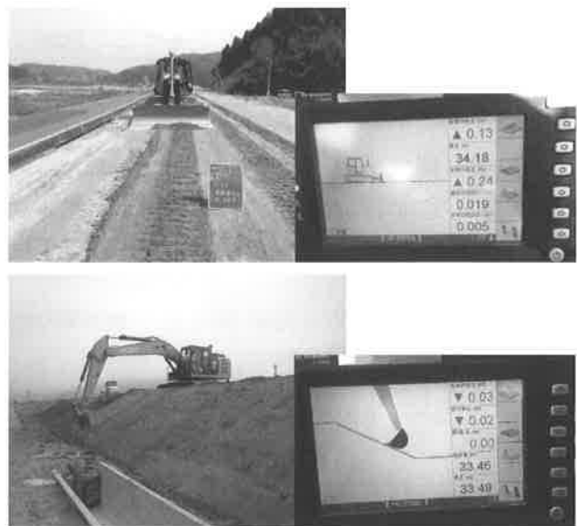
図-5 ICT建機による作業状況
