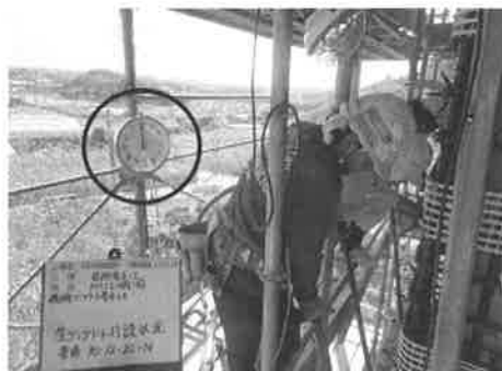
図-10 コンクリート打設締めめ状況
