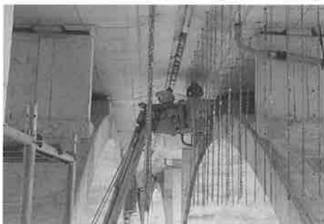
図-5 高所作業状況
