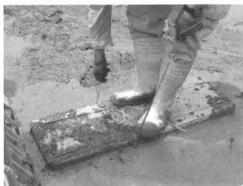
図-5 実工事における作業状況
