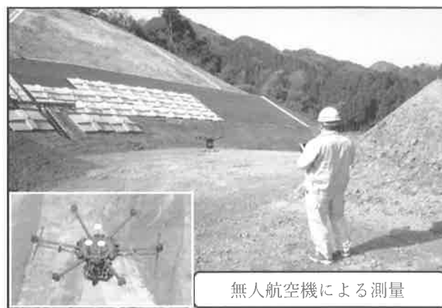
図-2 無人航空機による測量
