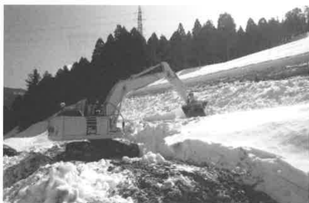
図-6 ICT建設機械での除雪作業
