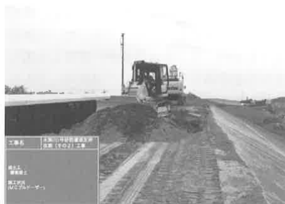
図-4 緩衝盛土ICT施工状況
