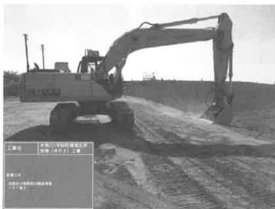
図-8 盛土端部の施工状況
