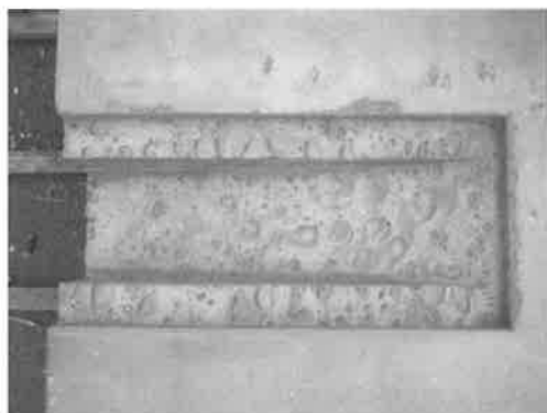
図-3 模擬試験体下面の気泡滞留状況
