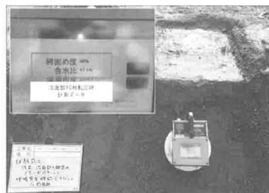
図-6 SDGによる計測状況
