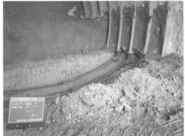
図-4 坑口部における沈下対策工(インバート支保)
