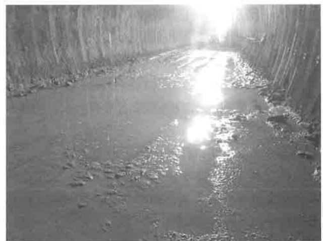
図-5 湧水による泥濁化
