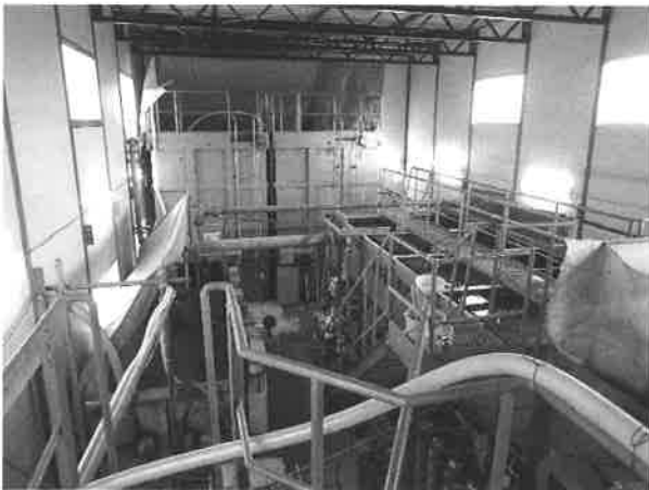
図-7 大型貯水槽設置 (20m 2 ・2基)
