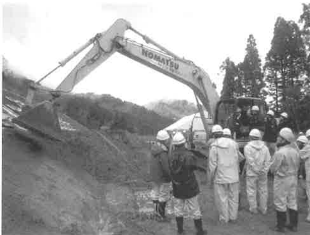
法面整形操縦状況
