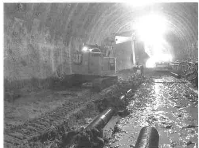
図-6 インバート下中央排水の施工
