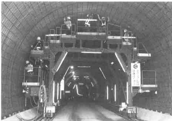
図-11 風管スペースのない鉄筋組立台車での作業状況
