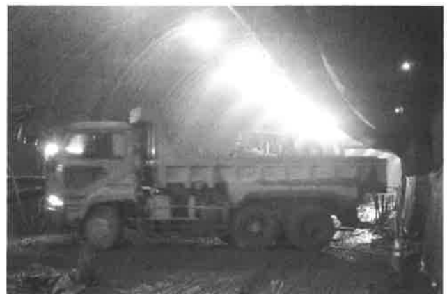
図-10 拡幅帯でのダンプ転回状況
