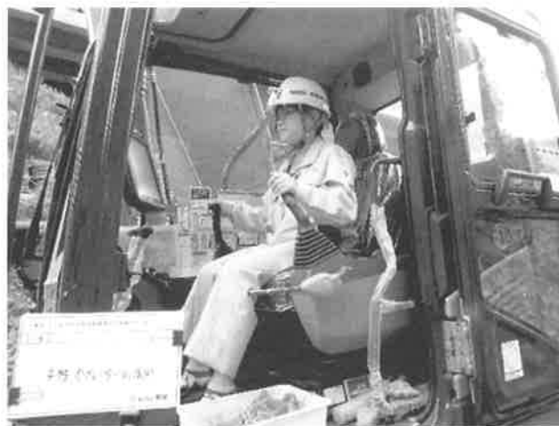
ICT建設機械の操縦
