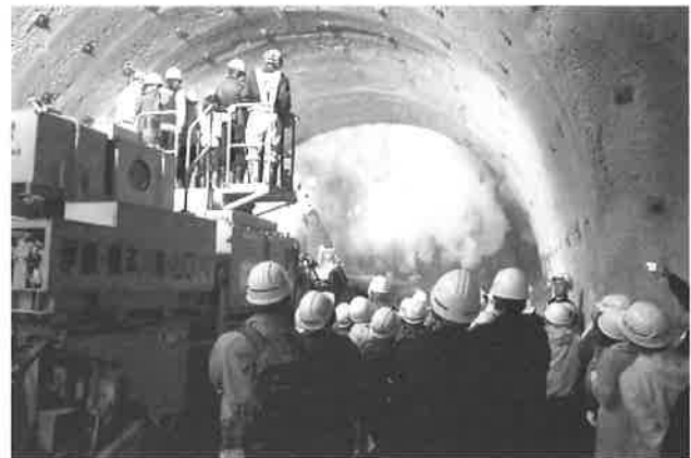
図-12 現場見学会の様子（掘削状況）
