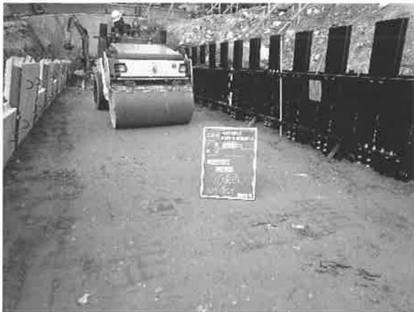
図-5 ソイルセメント転圧状況
