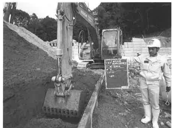
図-6 ソイルセメント本練状況
