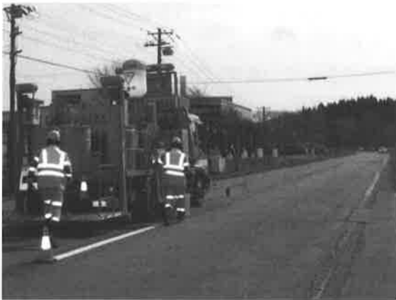
図-1 中央線の復旧状況
