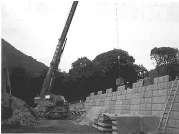
図-7 ソイルセメントの投入状況
