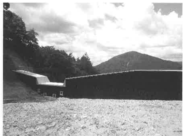
図-9 本堤完成（上流側）
