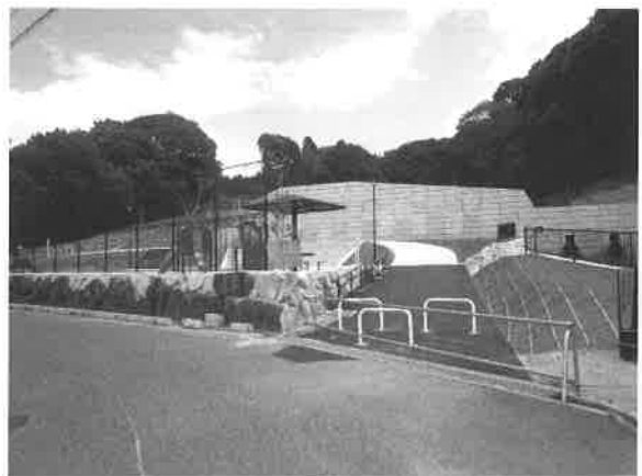
図-10 関連工事の公園完成
