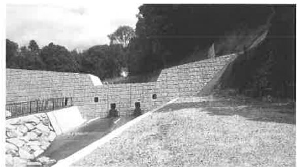
図-8 本堤完成（下流側）
