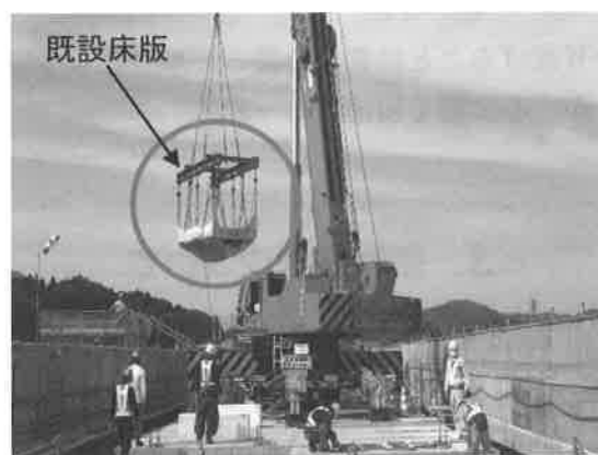
図-4 既設床版撤去
