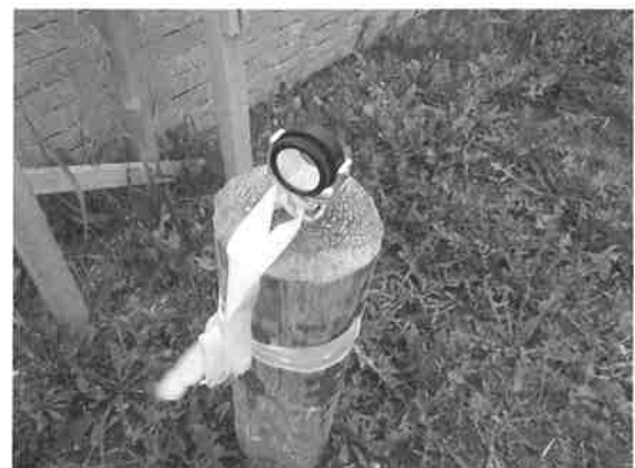
図-2 変位杭に取付けたプリズム
