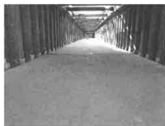
図-7 構造物構築
