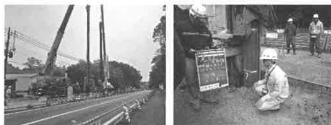
図-3 先行掘削圧入状況
