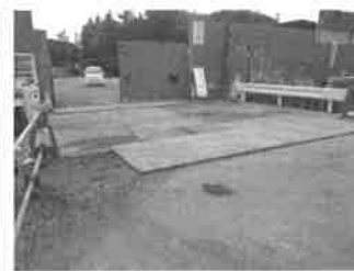
図-13 覆工板設置完了
