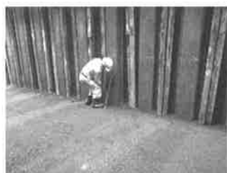
図-4 支持材設置（端太角）
