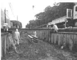
図-12 覆工板設置
