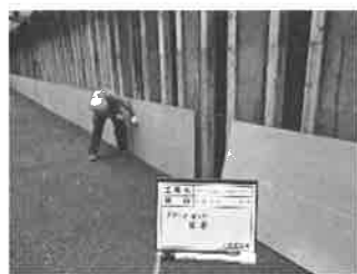
図-5 ゼロスペースボード設置
