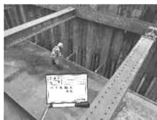
図-9 砂詰め（水締め）
