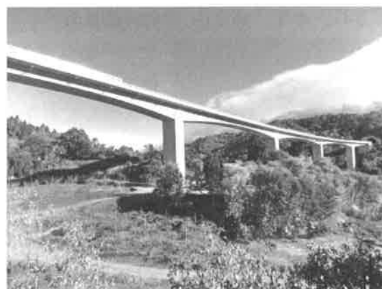
復興支援道路 相馬福島道路・月館高架橋
