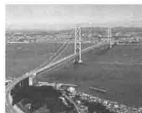
明石海峡大橋
