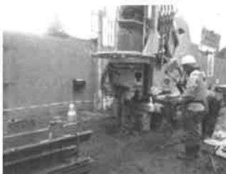
図-10 鋼矢板圧入
