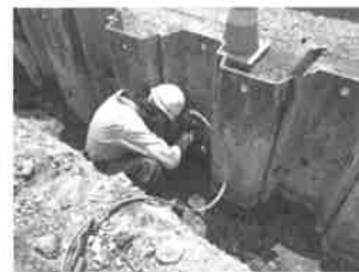
図-11 鋼矢板切断
