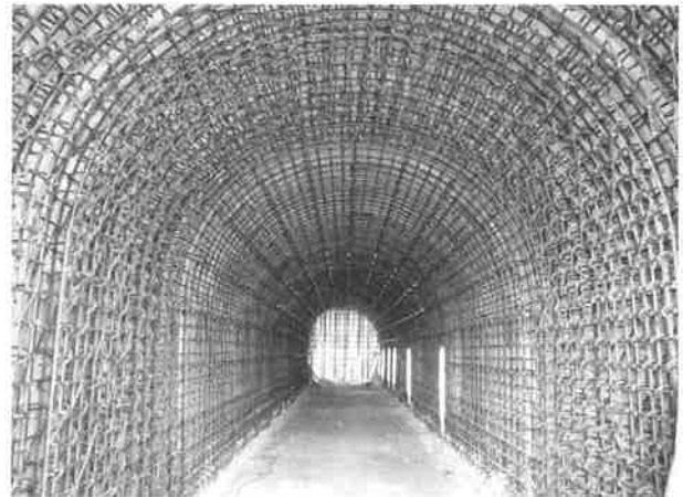
図6 シェルターの鉄筋写真
