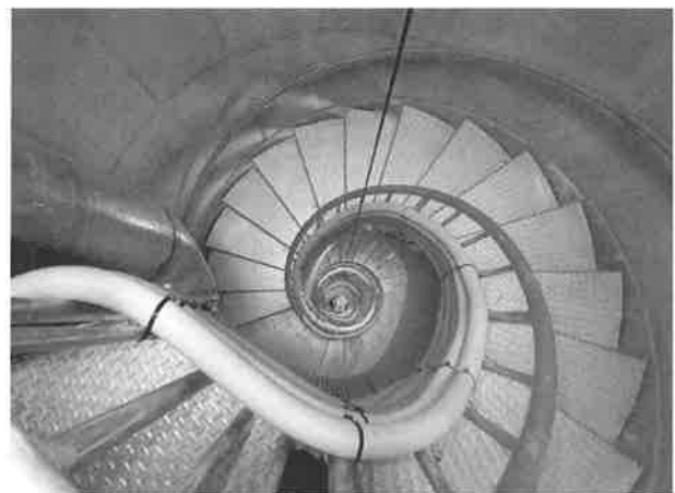
図4 上から立坑の螺旋階段を見る (白いパイプは手摺の足元に設置した電線パイプ)
