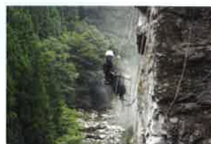
和田正大 様 [直壁削孔]
