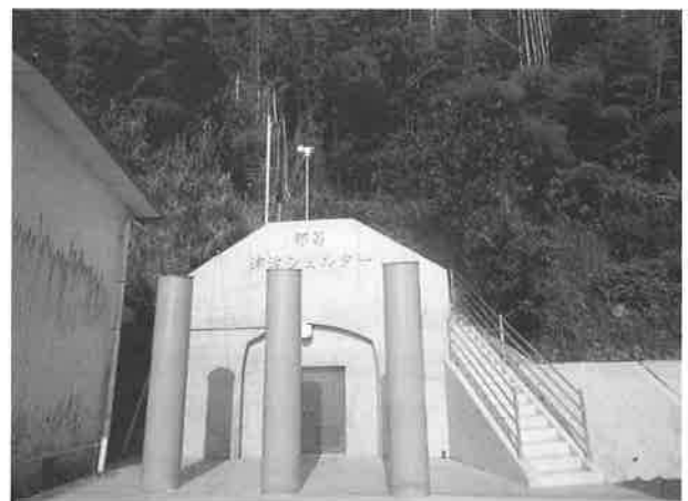
図8 完成写真 (3本の柱は津波漂流物の衝突防止杭)
