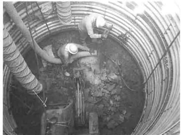
図3 砂岩中央部にセリ矢が数本打ち込まれている (下は小型バックホウ)
