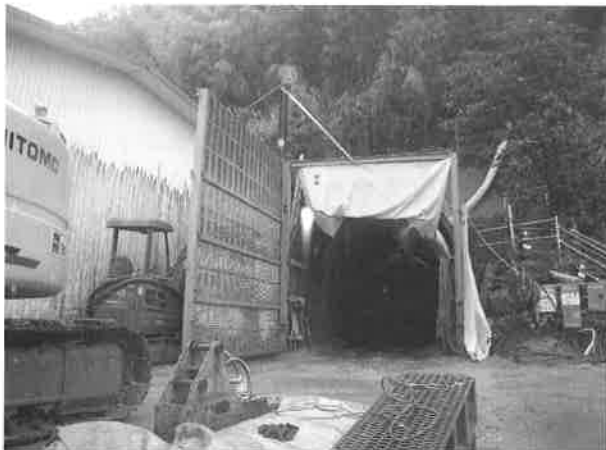
図5 騒音対策として防音シートに追加して防音扉を設置(左側)
