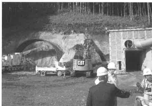
トンネル坑口の状況
