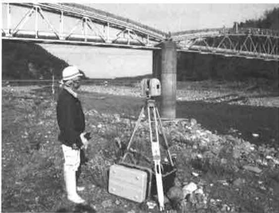
図-5 3Dレーザースキャナー測量状況
