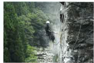
和田正大 様「直壁削孔」
