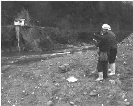
図-4 従来工法 TSによる3次元放射観測
