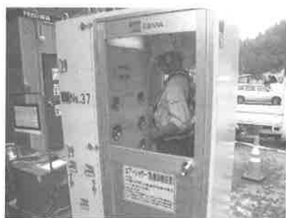
図-13 エアーシャワー機の設置
