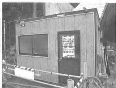
図-12 リフレッシュルームの設置
