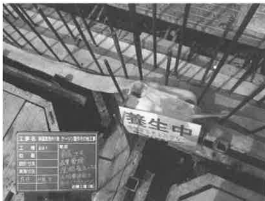
図-3 養生サポートタンク設置状況
