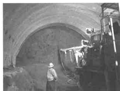
図-10 切羽コンクリート吹付け
