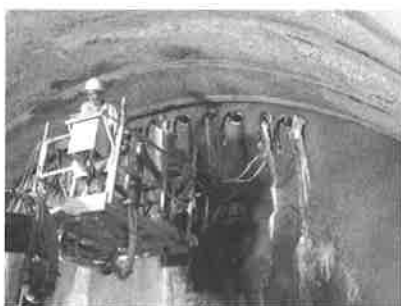
図-4 AGF工法 薬液注入状況
