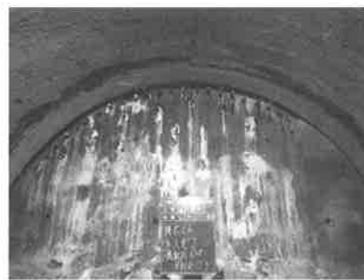
図-5 AGF工法+鏡ボルトの併用 1本当たり約150kg以上の薬液を注入（図-4）し、切羽には注入式長尺鏡ボルトL=13mを11本打込んだ。（図-5）
