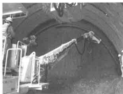
図-11 支保工建込専用機械の導入
