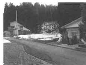
図-6 終点側坑口周辺
