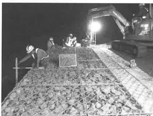
図-7 夜間作業状況(かご擁壁工・盛土工)
