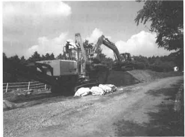
図-4 受入土（崩落土）改良状況
