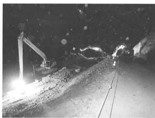
図-7 夜間作業状況(かご擁壁工・盛土工)
