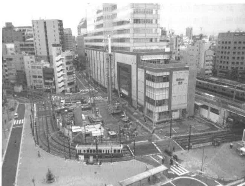
図-1 工事箇所全景写真
