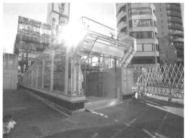
図-15 自転車駐車場出入口完成
