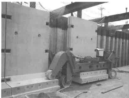
写真-4 プレキャスト擁壁据付状況
