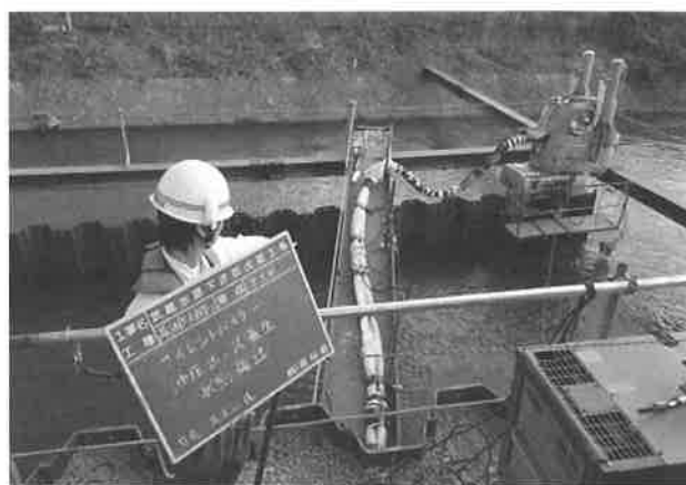
写真－8 油圧ホース養生状況
