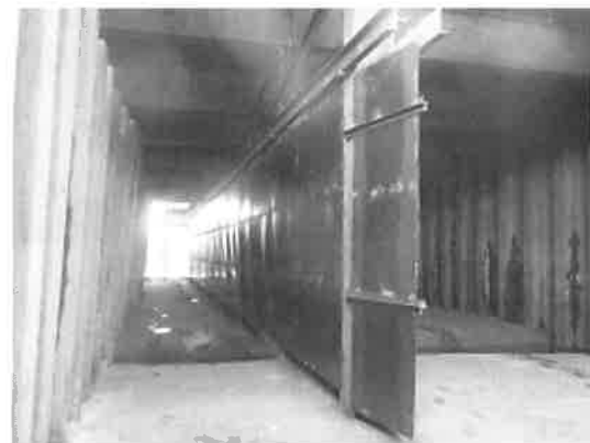
写真-6 杭間整流板設置
