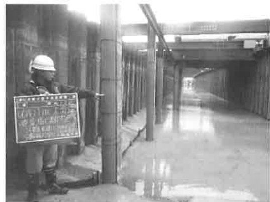
写真-5 塩ビ管挟み込み
