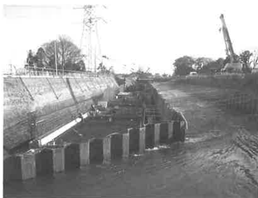
写真-3 右岸通水左岸構築状況
