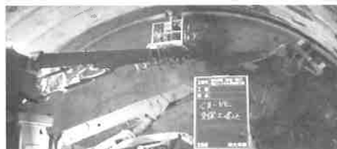
図-4 鋼アーチ支保工建込み状況
