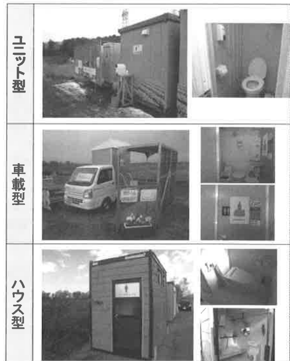
図ー1 H27モデル工事において導入した仮設トイレのタイプ
