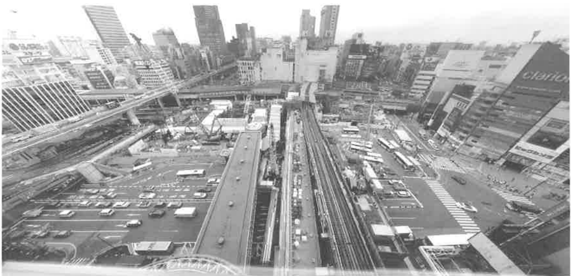
工事箇所全景写真（渋谷ヒカリエより）
