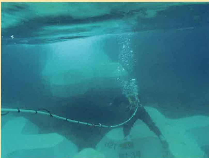
人工リーフ 被覆ブロック据付工 陸上からは見えない所で頑張ってます。
